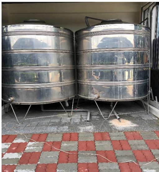
廚房水塔清洗過程
